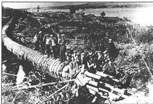
Рис. 2. Сооружение деревянного водопровода Уйской оросительной системы на левом берегу Енисея, 1938 г.
